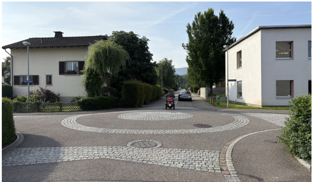
Abbildung 16: Beispiel angehobener Knoten Breiti-/Ulmenstrasse, Möhlin
