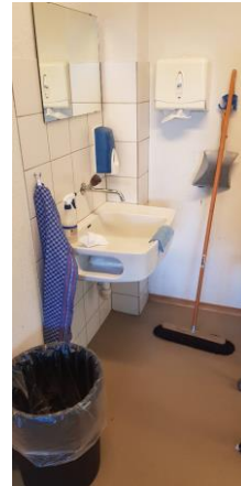
Waschrinne in Klassenzimmer aus Porzellan (nicht bei Steigzone)
