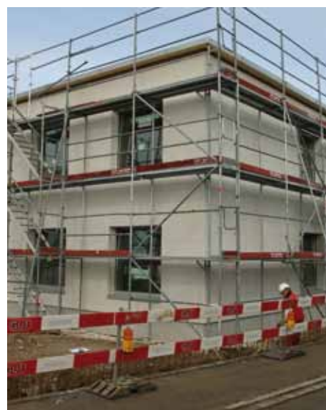
Bauarbeiten am Doppelkindergarten Breiti 2.
