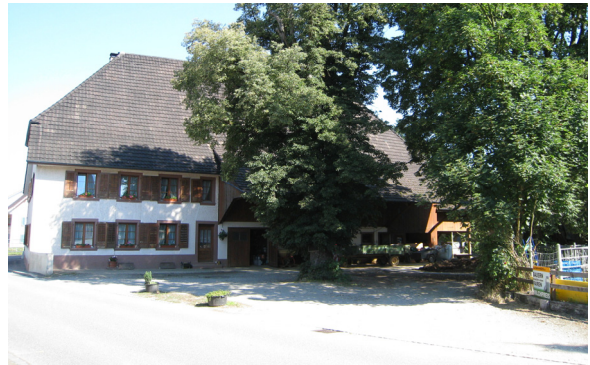
Abbildung 57: Kurzinventarobjekt als Volumenschutz: Bauerhaus
