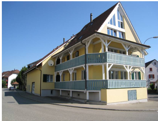
Abbildung 54: Kurzinventarobjekt als Volumenschutz: Wohnhaus und Scheune, Aeschengasse 8
