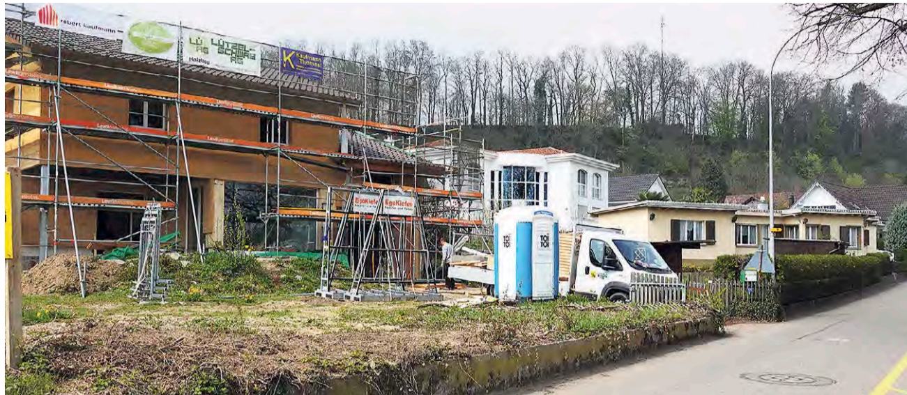
Die Sichtzone bei der Ein- und Ausfahrt an der Rheinstrasse 55 ist der Zankapfel.
